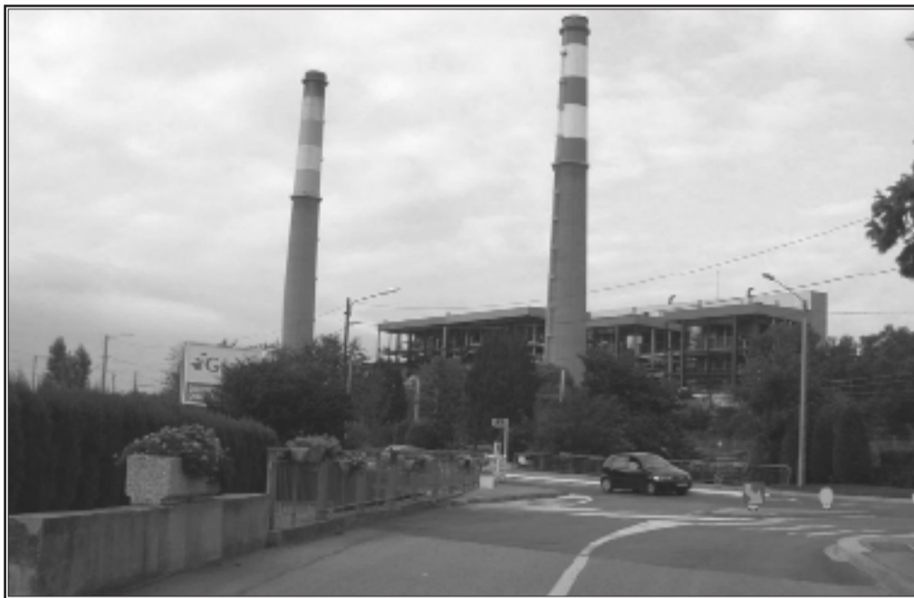
La centrale thermique de Loire située sur un site extrêmement porteur à cheval sur les communes de Givors et de Loire..
